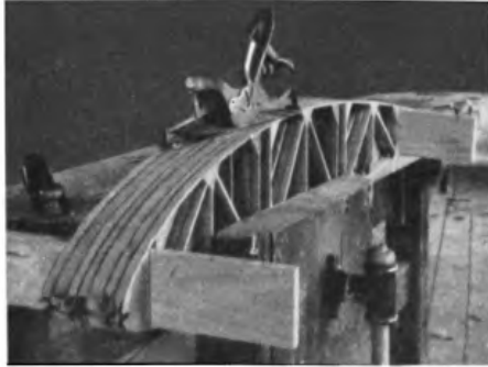
Abb 52. Beiputzen von Rippen.
