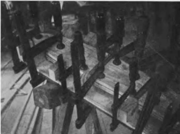
Abb. 49. Pressen der Rippe durch Beilagen und Zwingen.
