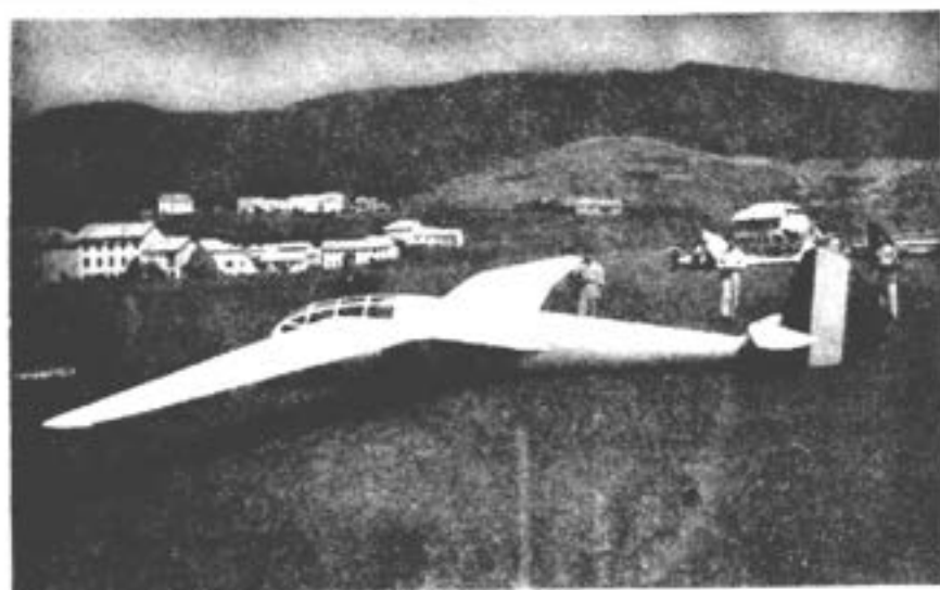
Fig. 59. - La snella sagoma del « Turbine », veleggiatore dall'elevato allungamento alare. (Foto G. L. Della Torre).
