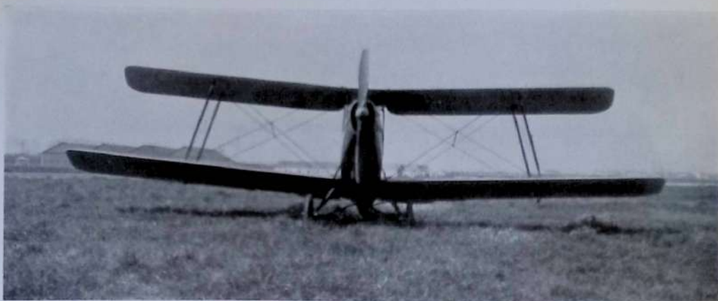
Tipo con motore a cilindri in linea raffreddati ad aria. Motore I. F. Asso 80/100 HP.
