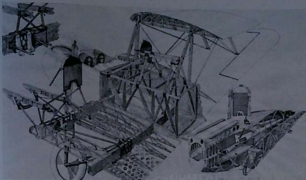
Dettagli costruttivi dei castelli motori.
