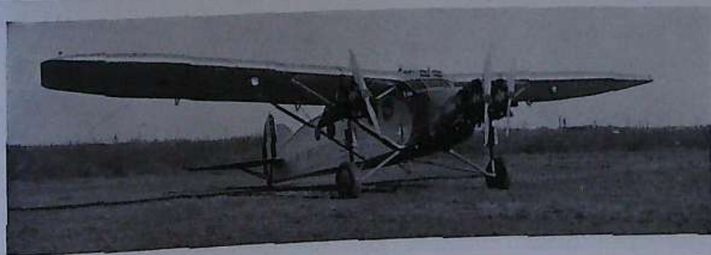
MONOPLANO CAPRONI 101 - Tipo con tre motori Stella P. VII. C. e sistemazioni interne militari.
