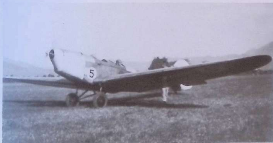
51. Sullo sfondo del Canto Alto ancora un prototipo dell'Ing. Pallavicino: il PS 1 (Pallavicino Sport N. 1) 2 - 4 posti, visibilità verso il basso, carrello retrattile - costruito in 2 esemplari nel 1934 appositamente per la coppa Challenge europea. La struttura tutta in tubi di acciaio saldati... furono costruiti in soli 8 mesi! Il n. 42 alla fine dei 20 giorni di gara si piazzò 18°, su 60 iscritti.
