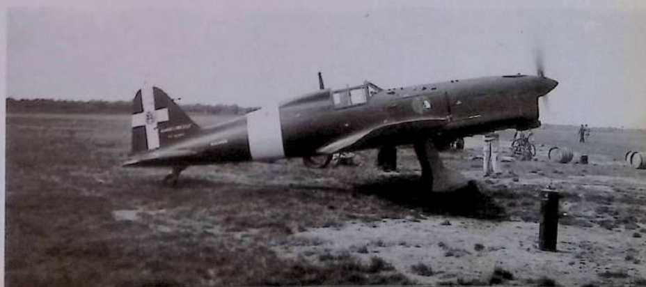
153. Questo motorista acconsentì a togliere il cofano (in legno, ma ben rinforzato) per farmi vedere il Delta... ci stava "tutto e appena", coi suoi 850 Cv, raffreddato ad aria.
