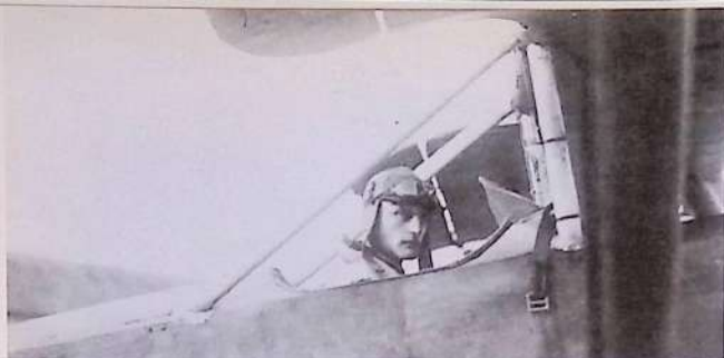
61. L'AS1 era di facile pilotaggio e sicuro nell'uso. L'ala "aperta" sopra il pilota, facilitava l'entrata - uscita e i due lunghi montanti all'indietro davano protezione.
