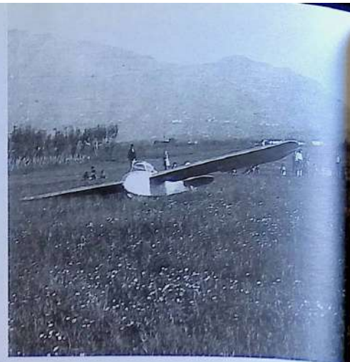
165. Solo un piccolo aliante - autocostruito - atterrò nel 1947 nell'erba alta di Tresolzio, lasciandovi una lieve traccia: era il S.AMBROGIO di Mantelli costruito in casa-garage (aiutato dal fratello Domenico e da specialisti ex Caproni). Il progetto era dell'ing. Della Torre del politecnico di Milano, che costruì nel 1938 il prototipo. Mantelli ne riprese nel '45 i disegni, lo costruì, lo collaudò in traino da FL3, da Orio al nostro Campo. Venne registrato poi I-MANT.
