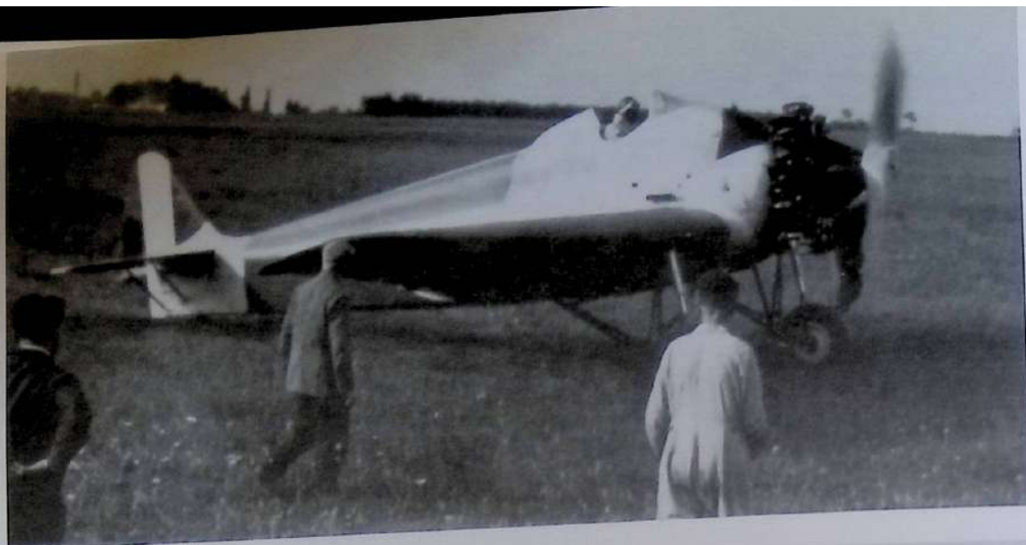
76. Parliamo un attimo degli aerei AP1 (Assalto Pall.1) che sono stati progettati dal 1934: vediamo appunto il prototipo al primo volo senza cofano motore, molto rustico...
