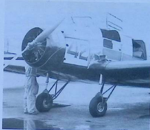
51. Sullo sfondo del Canto Alto ancora un prototipo dell'Ing. Pallavicino: il PS 1 (Pallavicino Sport N. 1) 2 - 4 posti, visibilità verso il basso, carrello retrattile - costruito in 2 esemplari nel 1934 appositamente per la coppa Challenge europea. La struttura tutta in tubi di acciaio saldati... furono costruiti in soli 8 mesi! Il n. 42 alla fine dei 20 giorni di gara si piazzò 18°, su 60 iscritti.
