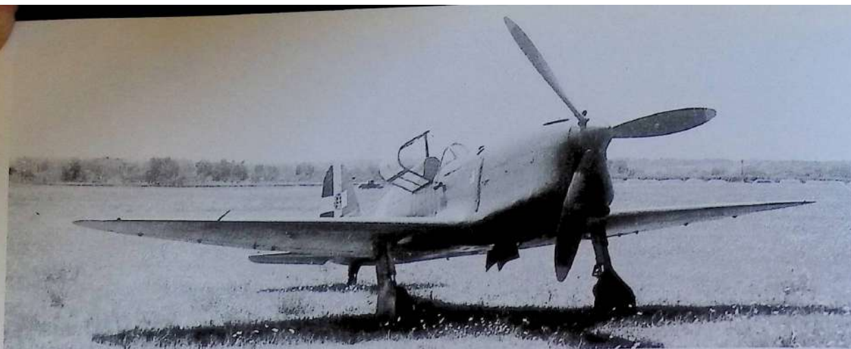
152. ...Una rarità: a Passignano sul Trasimeno, la SAI Ambrosini costruiva (oltre ai Macchi 202) anche i SAI 207! Stupendo aereo, interamente in legno, motore I.F. Delta, abbastanza fragile contro i "tutto metallo"... Non giunse mai in squadriglia.
