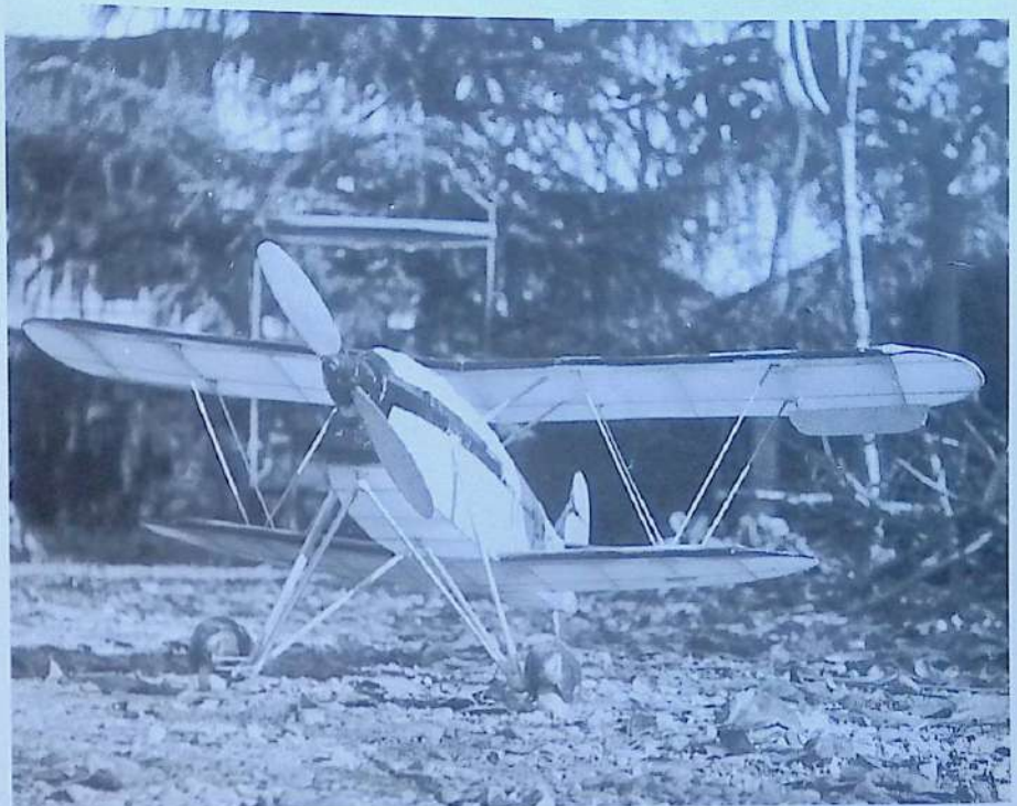
75. Nel frattempo, per sfogare la voglia di volo, il Mantelli si costruiva nel 1938 questo modello di CR 32 (con fantasiosa decorazione): 1 mt di apertura, matassa elastica, in scala quasi perfetta.
