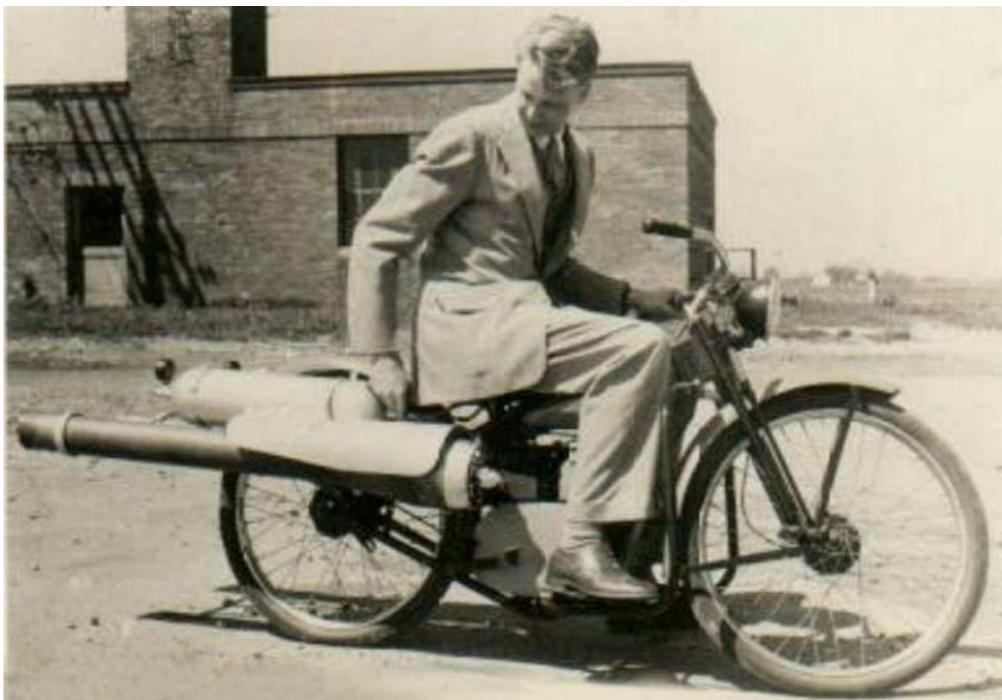
**Bill Tenney** in sella alla sua bici propulsa da una coppia di pulsogetti *D5-1*. Ciascuno dei *D5-1*, prodotti in meno di una dozzina di esemplari, faceva uso di 5 testate standard *Dyna-Jet* leggermente modificate, ed era in grado di fornire dalle 25 alle 35 lb di spinta. Per l'avviamento si faceva uso della bombola di aria compressa visibile dietro il sellino.
