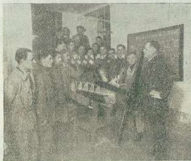
Reparto motori sezionati.
