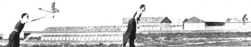
Fig. 148 - Il modello è ultimato, occorre verificarne il centraggio. L'aeromodellista lancia il modello in modo corretto ed osserva attentamente la traiettoria del volo planato. (Si noti l'elica monopala immobile).
