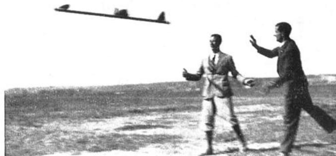
Fig. 154 - Un modello a tubo con due eliche e doppia deriva inizia il volo (anno 1929).
