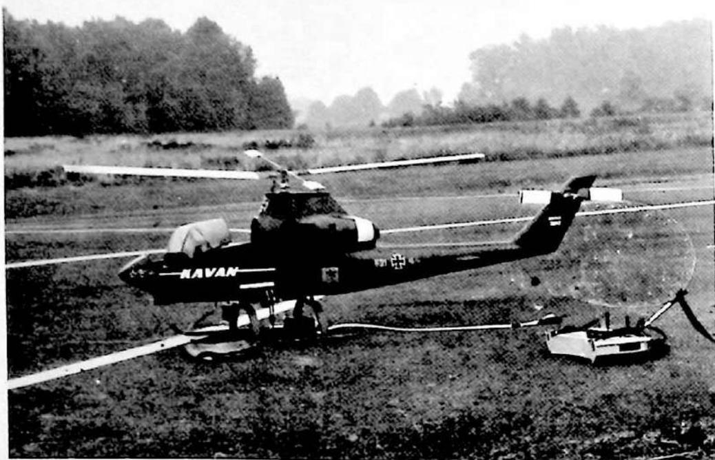
Un modello di elicottero radiocomandato: l'ultima e più avanzata espressione della tecnica aeromodellistica. E' capace di eseguire quasi tutte le evoluzioni di un vero elicottero.
