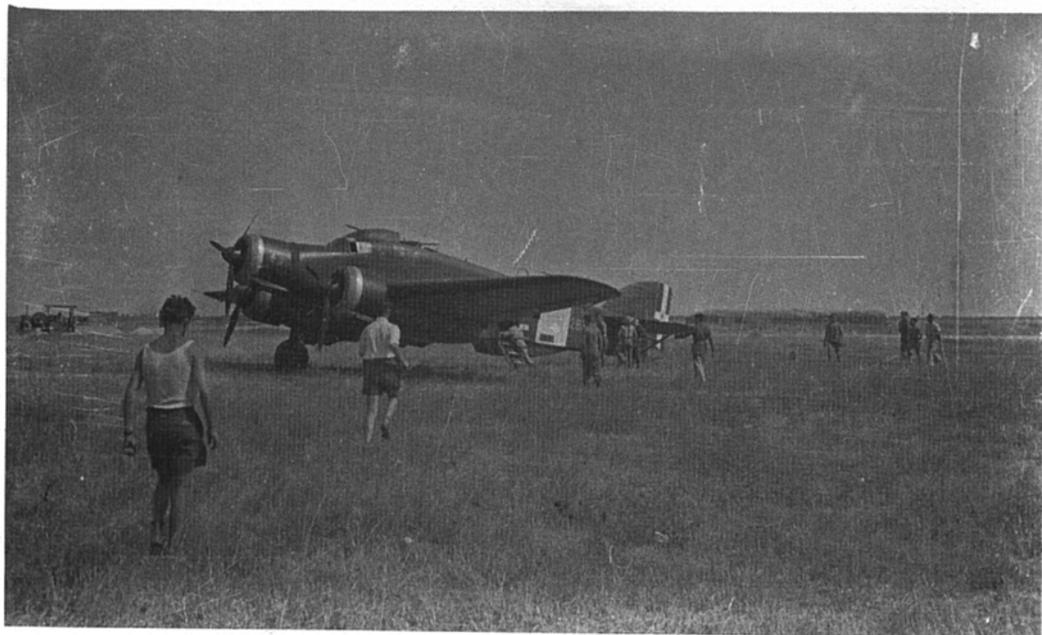
87- Un altro S.79 aerosilurante (notare la particolare forma allungata degli scarichi dei motori) con tinteggiatura uniforme delle superfici superiori in colore "verde oliva scuro 2" secondo lo schema standard metropolitano. L'immagine è stata scattata nell'estate 1942 sul campo di Cagliari-Elmas.
