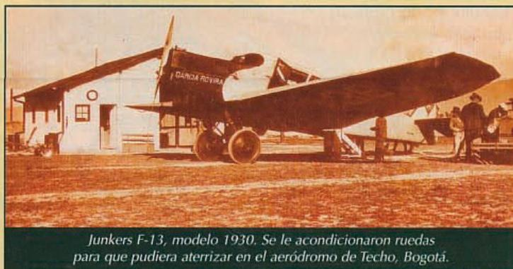
Junkers F-13, modelo 1930. Se le acondicionaron ruedas para que pudiera aterrizar en el aeródromo de Techo, Bogotá.
