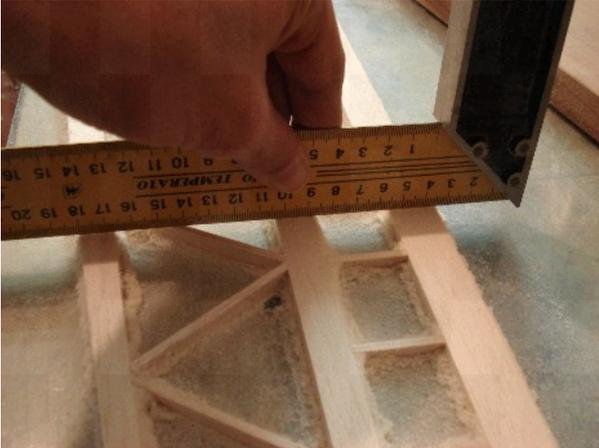
**Fig.3.** Con l'aiuto di una riga controllo la superficie che sia piana e non presenti irregolarità nel senso della corda...
