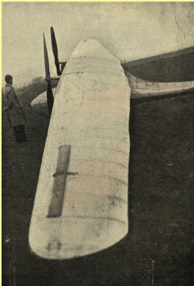
Il "pedaliante" riposa: notare le due eliche, e la forma molto affusolata della fusoliera.
