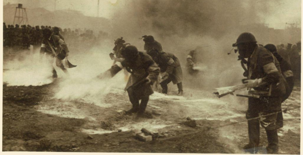
Bonifica del terreno durante recenti esercitazioni a Tokio
