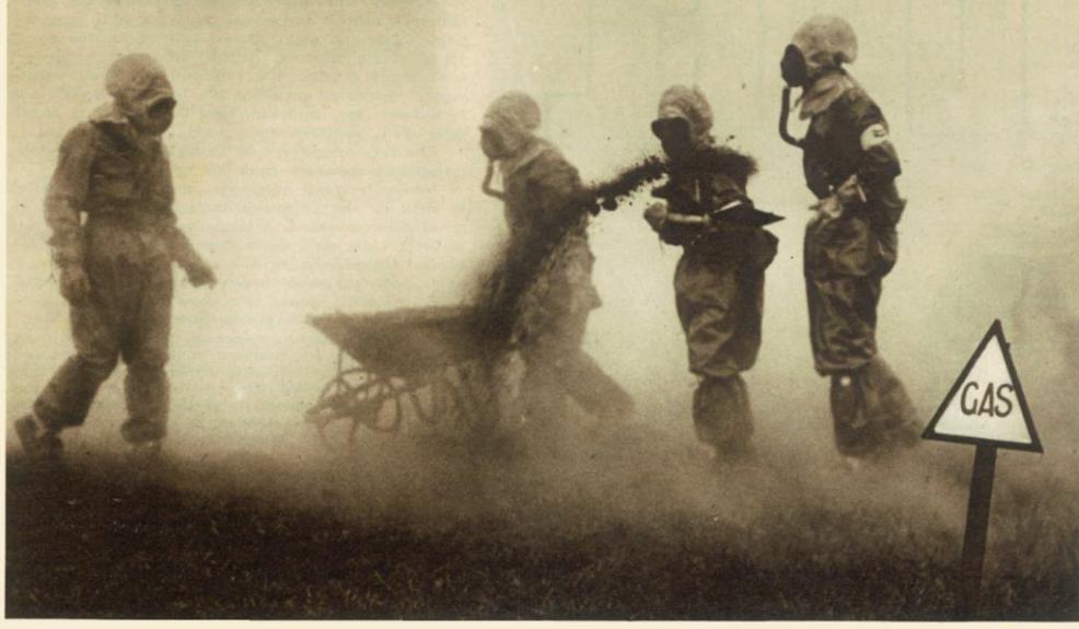
Disinfezione del suolo con getti di sostanze chimiche appropriate
