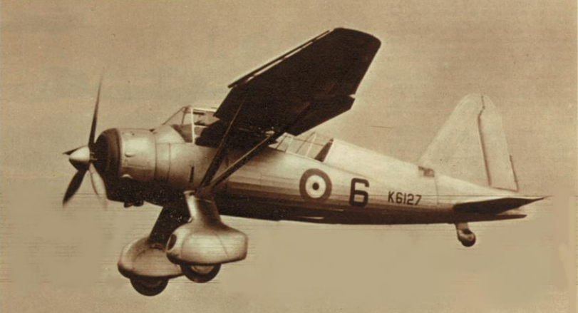
Il « Westland Lisander » è un monoplano ad ala alta costruito in gran serie per l'Arma Aerea britannica per impieghi di bombardamento leggero e ricognizione. L'ala ha una caratteristica forma in pianta: le semiali sono rastremate tanto verso le estremità come verso l'attacco, acquistando così un aspetto romboidale. L'ala nel centro è munita di trasparenti, permettendo la più ampia visibilità possibile alla luminosa cabina dove trovano posto un pilota ed un osservatore. L'armamento difensivo consiste in due mitragliatrici fisse e in una brandeggiabile comandata dall'osservatore. Una caratteristica notevole di questo velivolo sta nel fatto che ai lati esterni delle capottature delle ruote si possono adattare, per le missioni di bombardamento, due speciali supporti portabombe di facile smontaggio. Il motore del « Westland » è un « Bristol Mercury ». La sua velocità massima è di circa 350 km.
