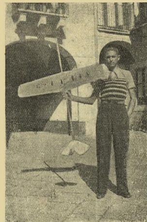
Un aeromodello a tubo del catanese Carlo Alberti, che ha imparato a costruire seguendo le lezioni di Giaretta. Lunghezza del modello mm. 1300, apertura alare mm. 1100.
